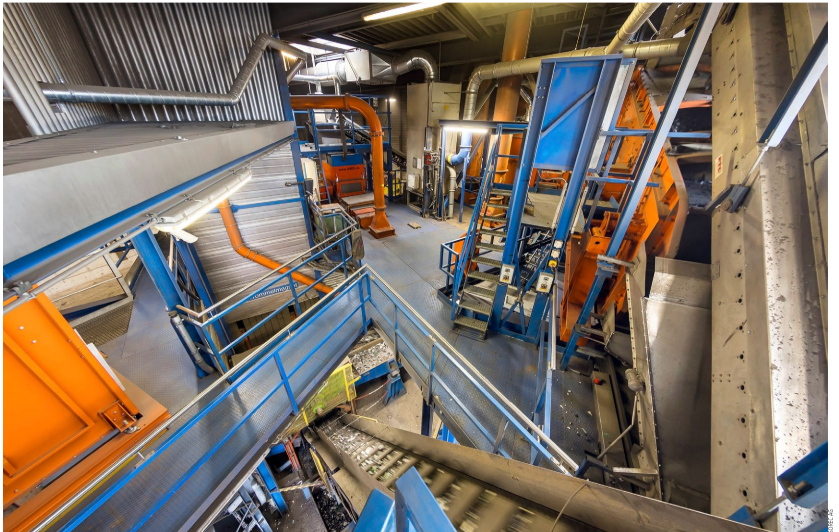
Mechanische Trennung: Das nichtmagnetische Material wird bei Sorec mit Abscheidern und Sieben aufgrund physikalischer Eigenschaften getrennt.
