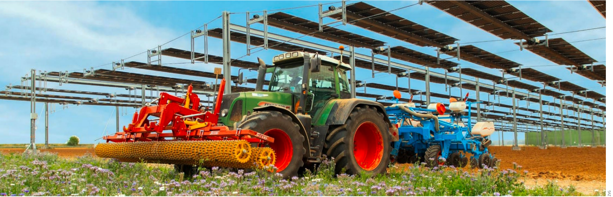
Photovoltaik: Die rotierbaren Solarpanels über den Feldern werden von einer Seilbaukonstruktion der Firma Brugg gehalten. Zusatzeffekt: Dank dem Schattenwurf der Anlage muss weniger bewässert werden.
